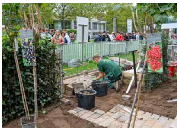
Zahlreiche Zuschauende verfolgen jeden Arbeitsschritt ganz genau.
